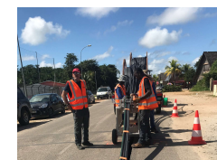
Installation de la fibre optique Saint-Laurent du Maroni
